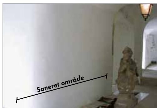
Efter sanering med Seccopor
