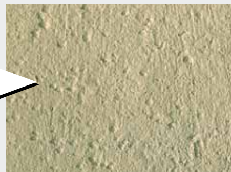
Mellemstrygning hhv. afsluttende stryging med KEIM Granital
